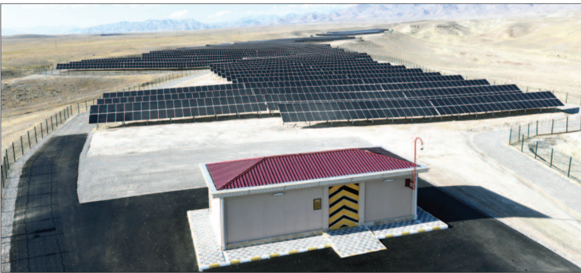
Kəngərli rayonunda 3 meqavat gücündə Günəş Elektrik Stansiyası
