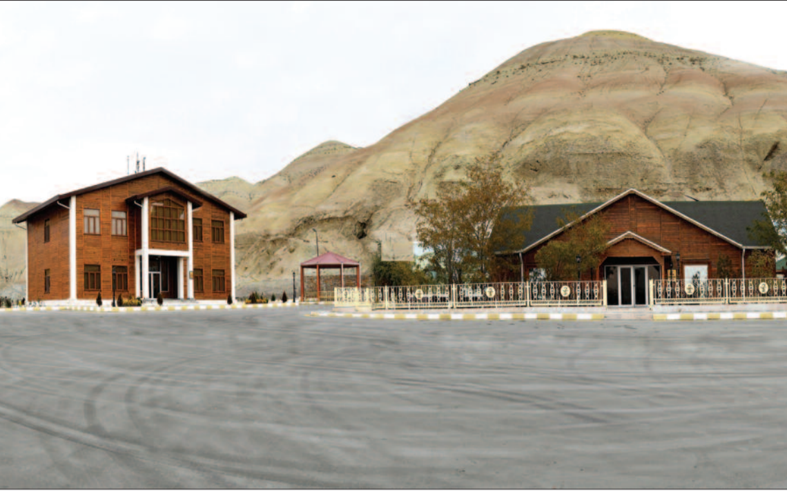
Naxçıvan Duzdağ Fizioterapiya Mərkəzinin inzibati binası
