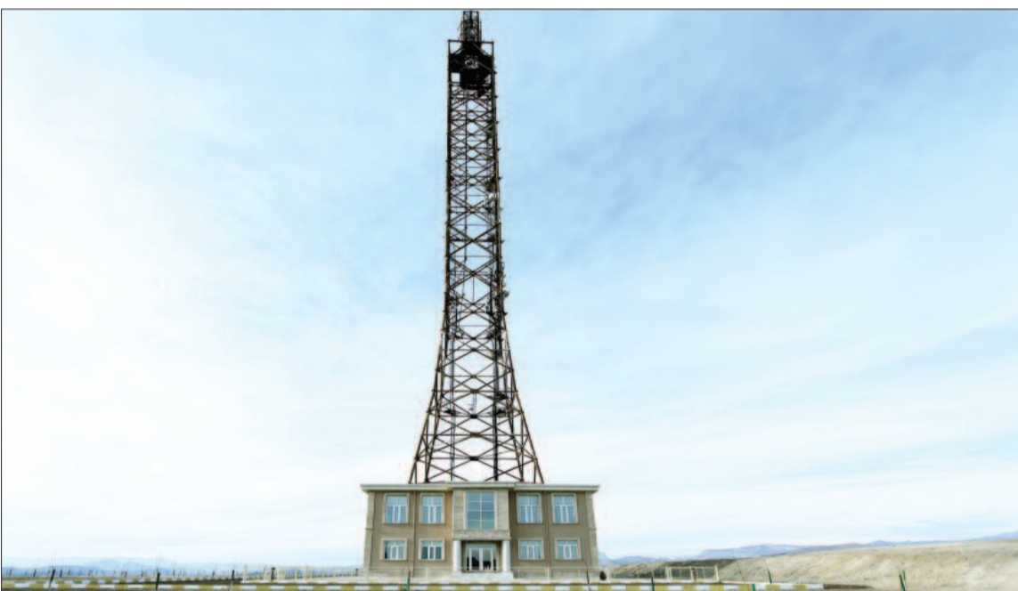
Ordubad rayonunda Dəstə Radio-Televiziya Ötürücü Stansiyası
