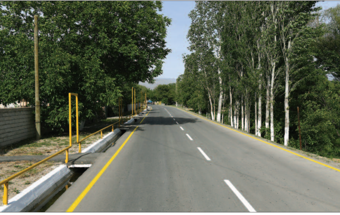
Şərur rayonunda Qarxun-Muğancıq-Mehrab-Məmmədsabir kənd avtomobil yolu
